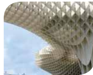
Şekil 3.5. Teknolojik yapısal ahşap elemanların kullanımı: LVL
