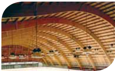
Şekil 3.4. T Günümüzden tutkallı lamine Ahşap buz pateni yapısı. A.B.D. Norman Foster
