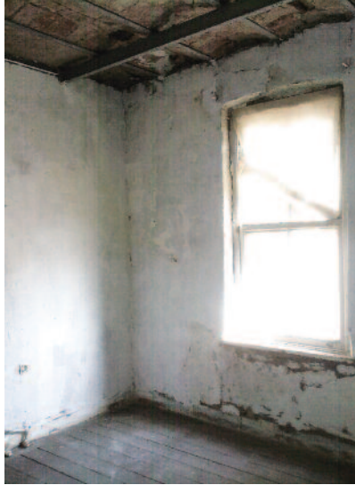
Renovasyon Öncesi İç Mekan Görüntüsü ▶
