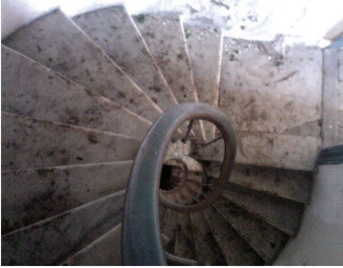
▲ Renovasyon Öncesi Merdiven Görüntüsü
